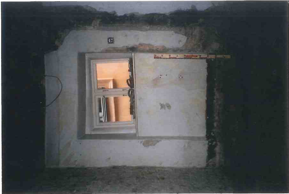
F4/18. Rum 402. Delvis igenmurad fönsteröppning i östra väggen som har ytterligare 3 st helt igenmurade öppningar av samma typ. Badrumsinredningen är nedriven.
