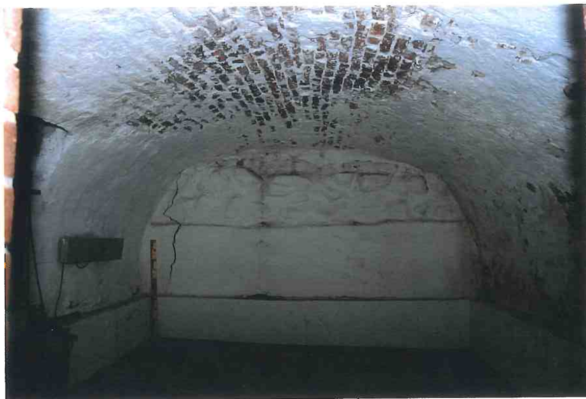
F1/15. Rum 001 mot söder. Källaren är uppförd med grundmurar av gråsten som bär tegelvalv. Betongsargen och betonggolven tillkom på 1970-talet. Observera puts- och tegelvittringen i valvet.
