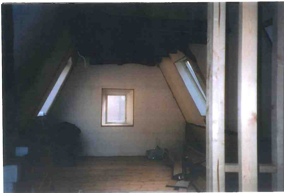
F6/18. Rum 501. Våningen mot N med fönster i norra gaveln.
