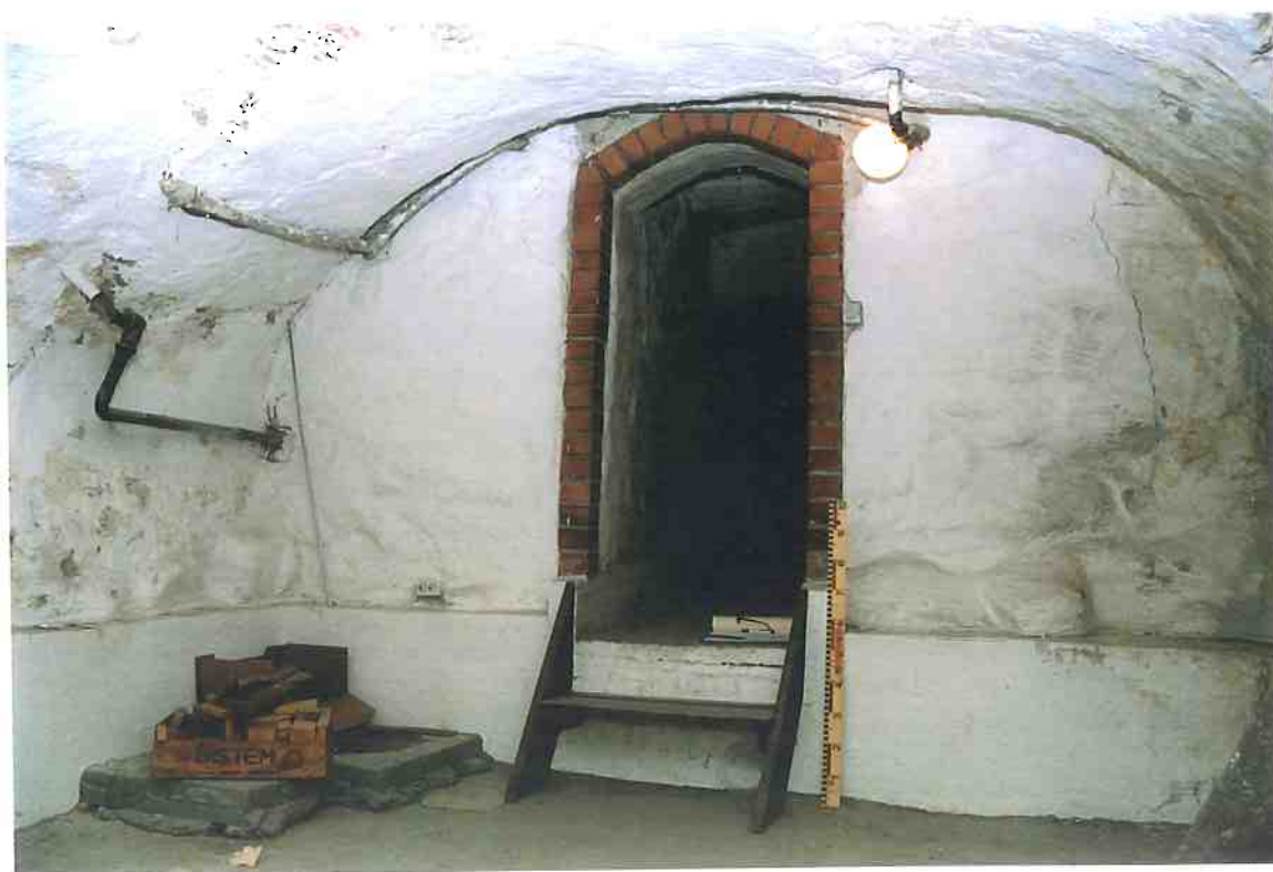
F1/19. Rum 001 mot norr. Dörromfattningen är troligen fr. 1970-talets ombyggnad. I NV-hörnet finns en provgrop med anknytning till grundförstärkningen. Observera att golvet är ca 50 cm lägre än i de norra rummen.
