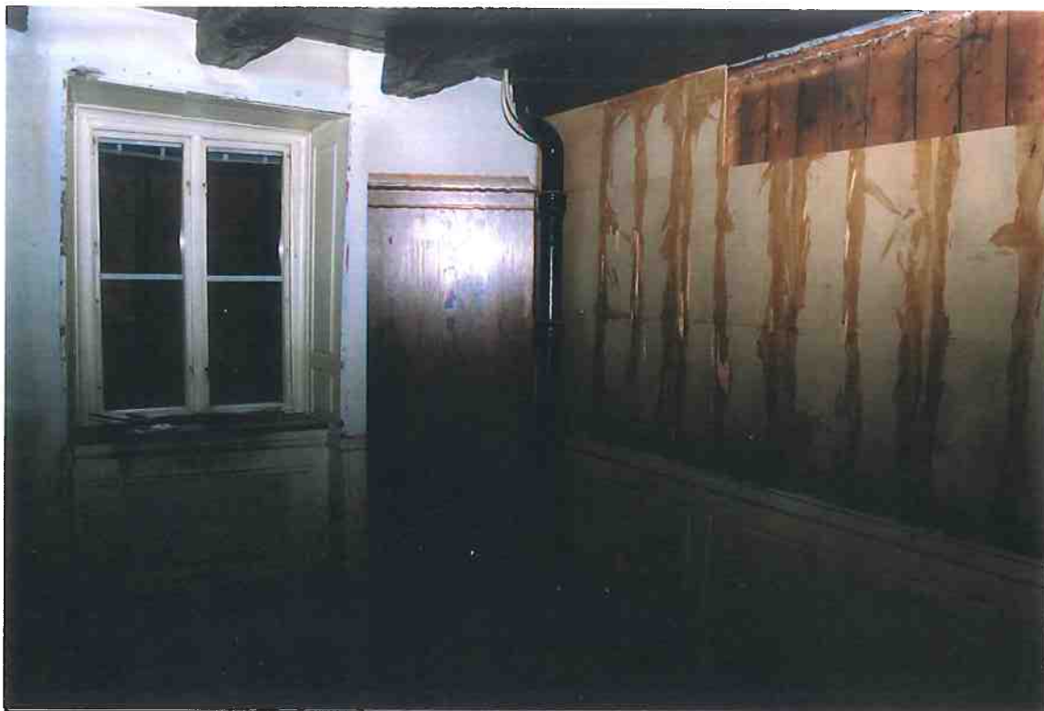
F3/9. Rum 201. I rummets SO-hörn finns slangenombrott av avlopps- och vatteninstallationer från 1970-talet. Rummet har bröst- och smygpanel från troligen 1800-talets första hälft. Södra väggen (till höger på bilden) är övertäckt med en äldre plankvägg som i sin tur övertäcktes med spånplattor på 1970-talet. Bakom den gamla plankväggen finns rester av gammal taklist och olika äldre väggtapeter.
