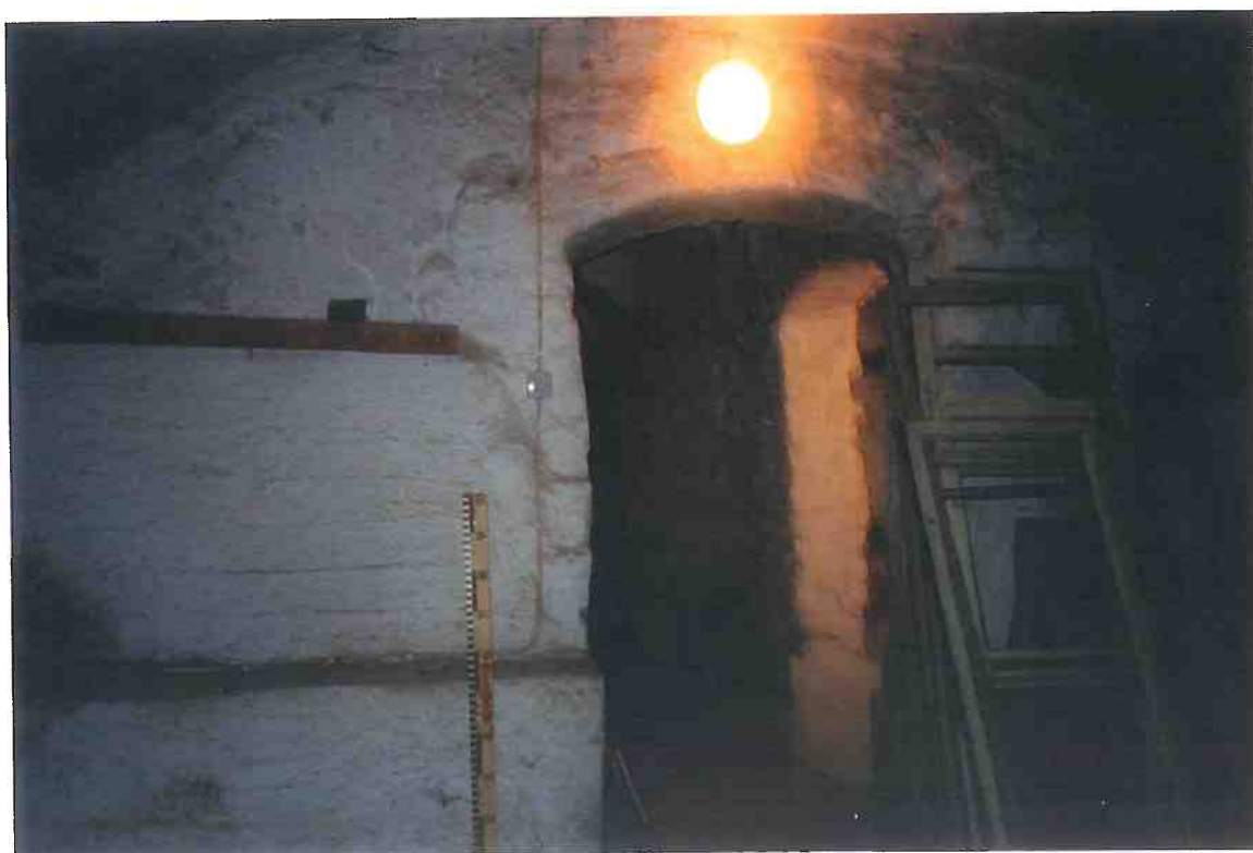
F2/3; F2/1. Rum 005 fr. N. Konstruktionen är genomgående i hela källaren; grundmur av murade gråstenar och tegelvalv. Betonggolv och betongsarg är tillägg från 1970-talet. I rummets östra mur finns som i övriga rummen en öppning i form av källarlugg.
