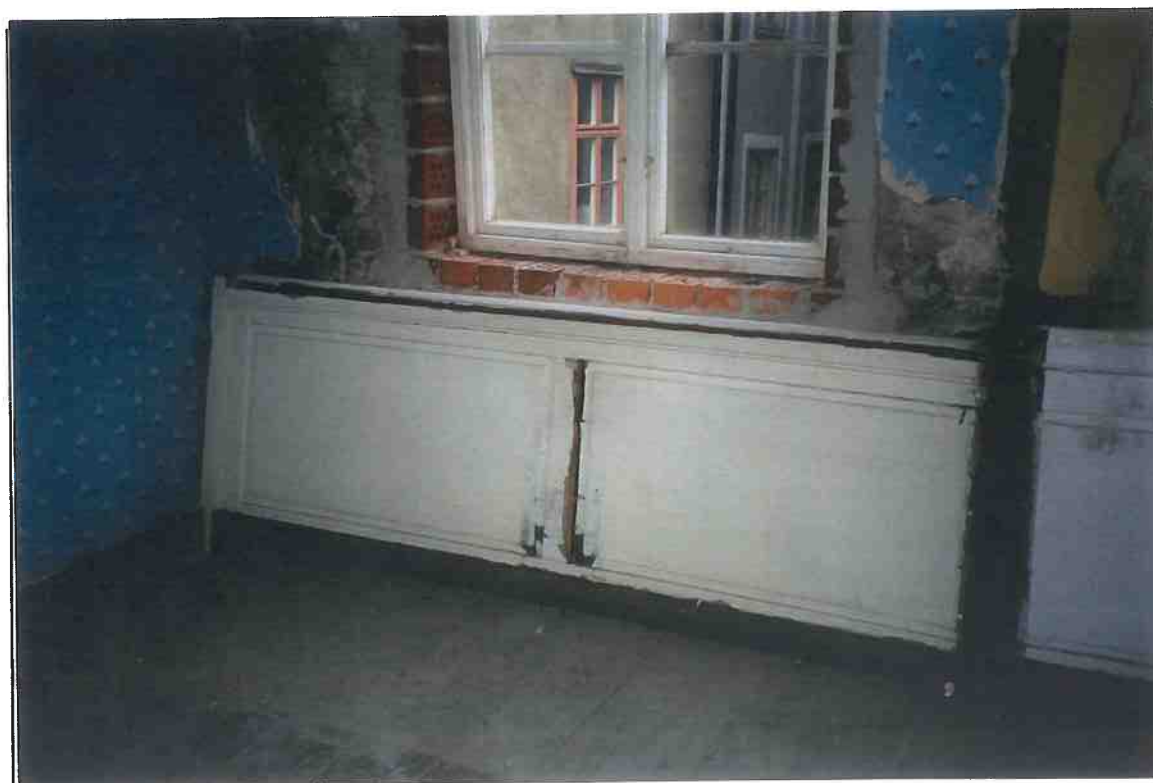
F6/3. Norra väggen i husets gavel. Nyinsatta fönster och nedmonterad bröstpanel.
