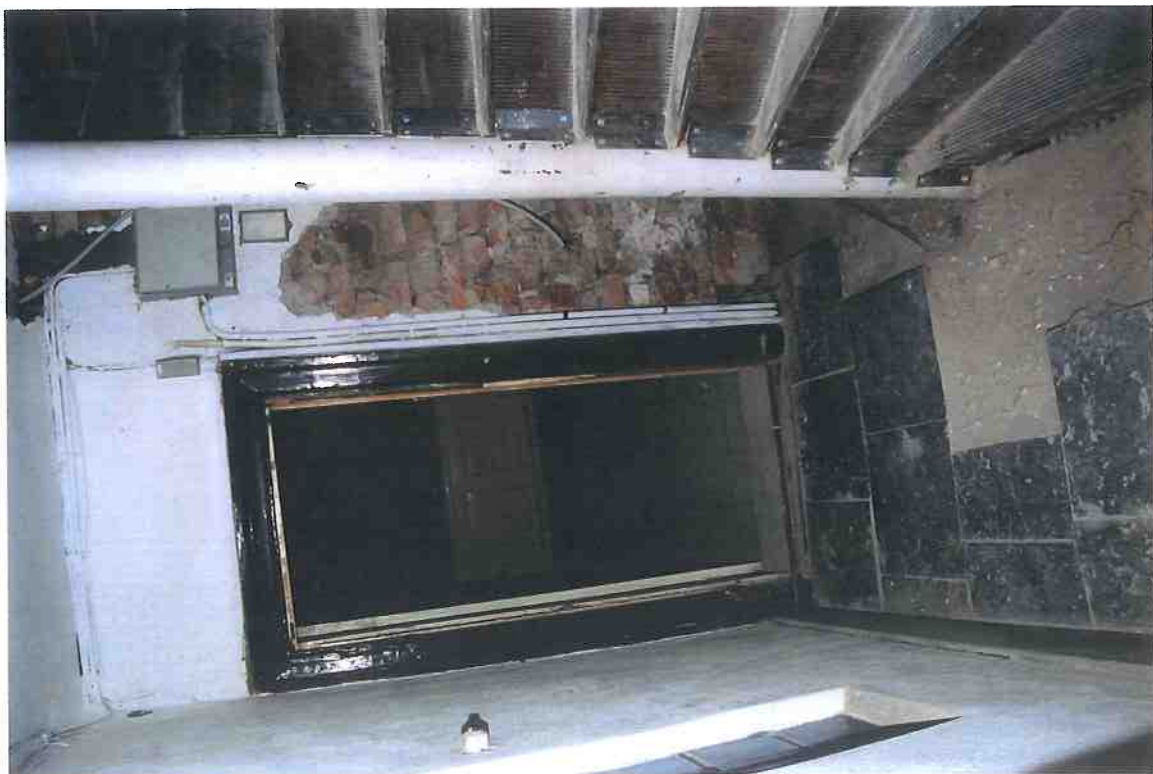
F3/10-11. Rum 203. Trapplanen präglas av järntrappans förbindelse mellan våningarna. Kalkstensgolvet är troligen från senare delen av 1800-talet och lagt över ett äldre brädgolv. Dörrfodren är av 1800-tals typ.
