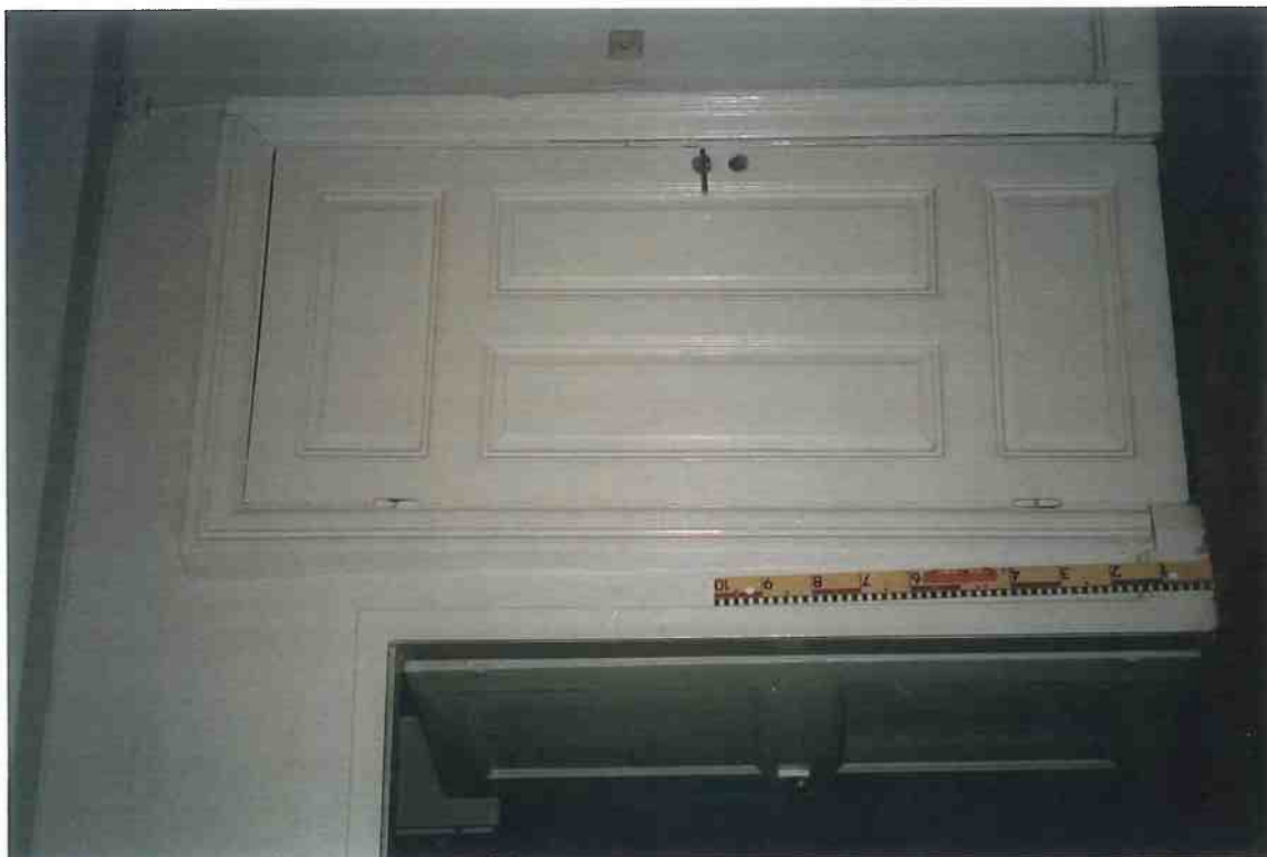
F4/5. Rum 304. Rummets dörr mot trapphuset (till höger) speglar en ombyggnad från 1800-talets slut medan den låga dörren till höger tillhör husets begynnelse, 1600-talet.
