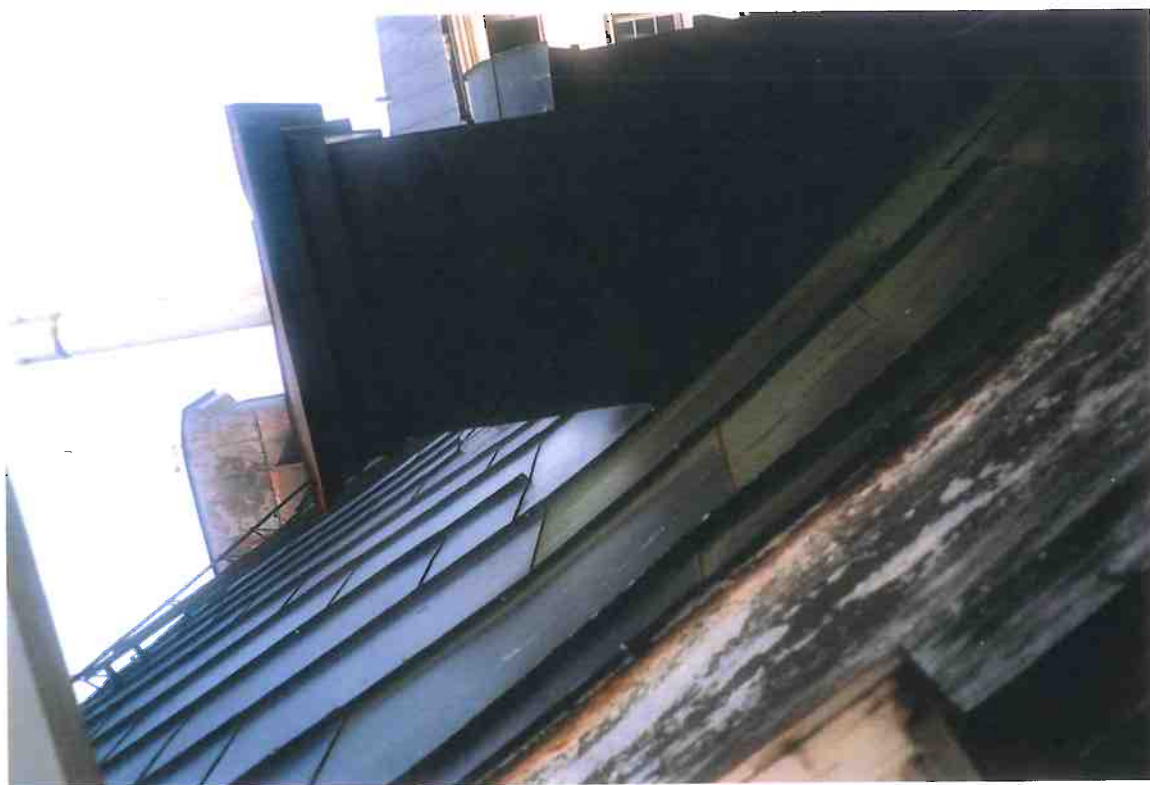
F6/26. Takets nuvarande utförande är därmed modernt och infördes någon gång mellan 1911 och 1928. Taket är svartmålat och täckt med plåtskivor med förskjutna tvärfalsar i halva plåtlängden, ett utförande som infördes på 1920-talet.
