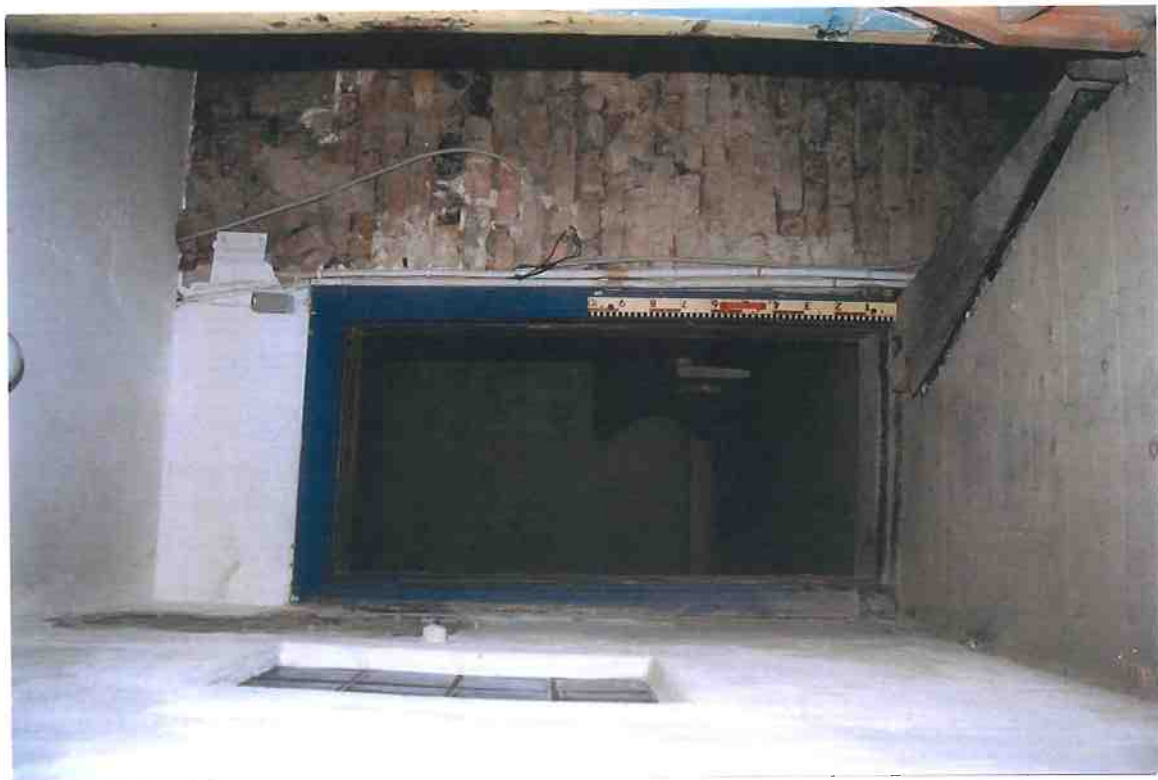
F3/19, F3/24. Rum 303. I höjd med plan III övergår gjutjärnstrappan (tidigare stentrappa) till trätrappa. Norra och södra dörrarna är från olika perioder och har därför olika höjder. I trapphusets östra vägg, mot nuvarande kök, finns resterna efter en forna dörröppning som på 1970-talet gjordes om till innerfönster med murat kepplerglas.
