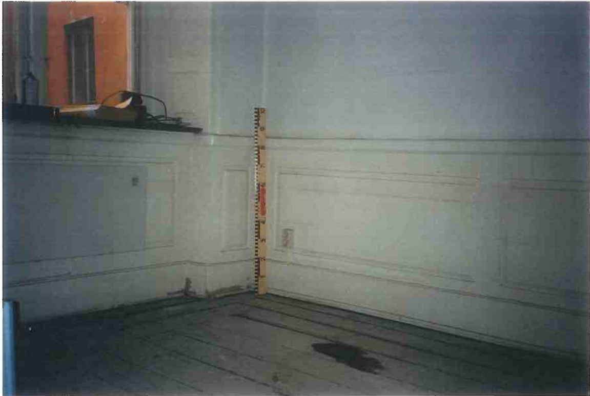
F2/10. Rum 204. Detalj av bröstpanel, fönsternisch och brädgolv i rummets NO-hörn. Golvet har frisbräddor i två led. Panelen är troligen från 1800-talets första hälft. Väggytorna är övertäckta med glasfiberväv.
