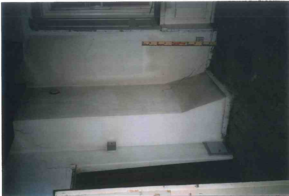
F2/21. Rum 201. Rummet mot NO. Kakelugnen revs troligen på 1970-talet. Dragspel dörren mot badrummet (202) är från samma period.
