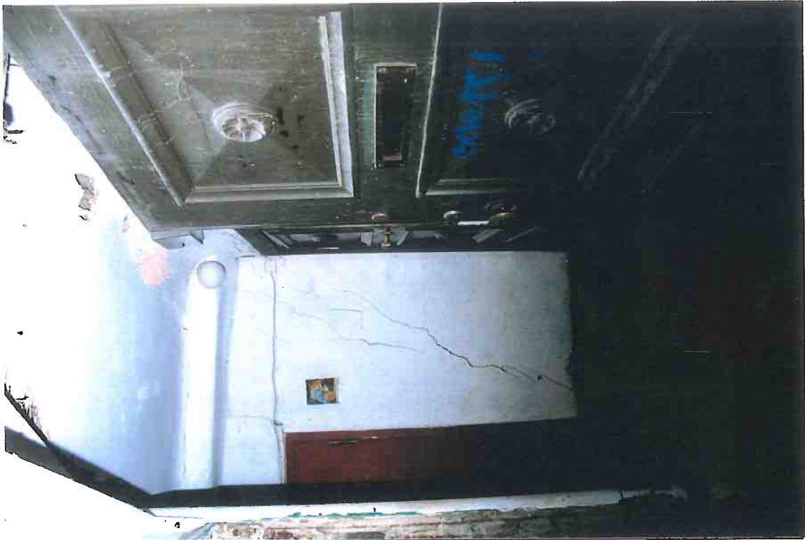
F1/7, F1/9. Rum 103. Entrédörren till fastigheten och dörren (DD 103/V-S) mot rum 101 är stildörrar som insattes troligen i samband med upprustningen på 1970-talet. Trapphusets tak är täckt med gips eller puts på vassbädd. I väggarna syns sprickbildningen orsakad av husets sättning.
