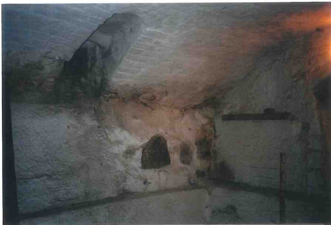
F2/3; F2/1. Rum 005 fr. N. Konstruktionen är genomgående i hela källaren; grundmur av murade gråstenar och tegelvalv. Betonggolv och betongsarg är tillägg från 1970-talet. I rummets östra mur finns som i övriga rummen en öppning i form av källarlugg.
