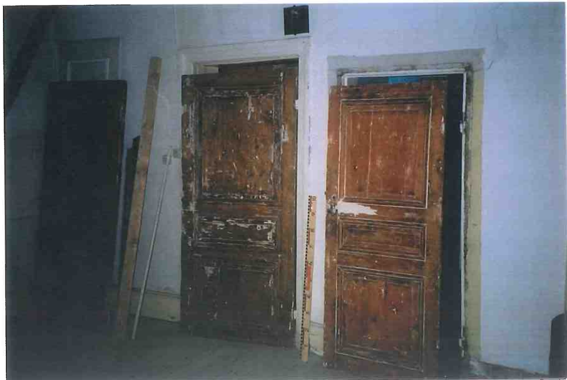
F4/3. Rum 301. Dörr D301/N-1 till vänster har fransk indelning, en typ som förekom mellan 1700-talets mitt och 1870-talet. Dörr D301/N-2 till höger med symmetriska speglar är av en typ som framställdes mellan 1820-1850.
