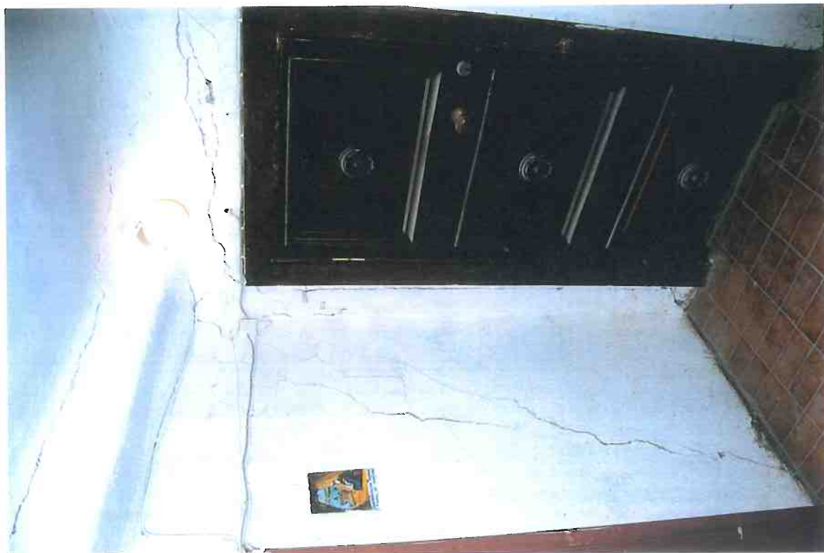
F1/7, F1/9. Rum 103. Entrédörren till fastigheten och dörren (DD 103/V-S) mot rum 101 är stildörrar som insattes troligen i samband med upprustningen på 1970-talet. Trapphusets tak är täckt med gips eller puts på vassbädd. I väggarna syns sprickbildningen orsakad av husets sättning.
