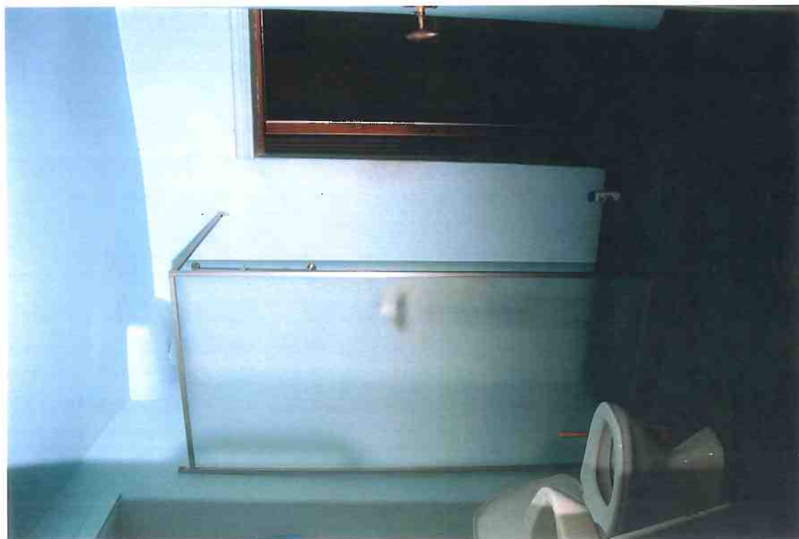
F3/2-3. Rum 202. Våtrummet är helt präglad av 1970-talets upprustning. Dörren i N (D204/S-1) mot rum 204 är en dörrtyp som förekom mellan 1700-talets mitt och 1800-talets senare del.
