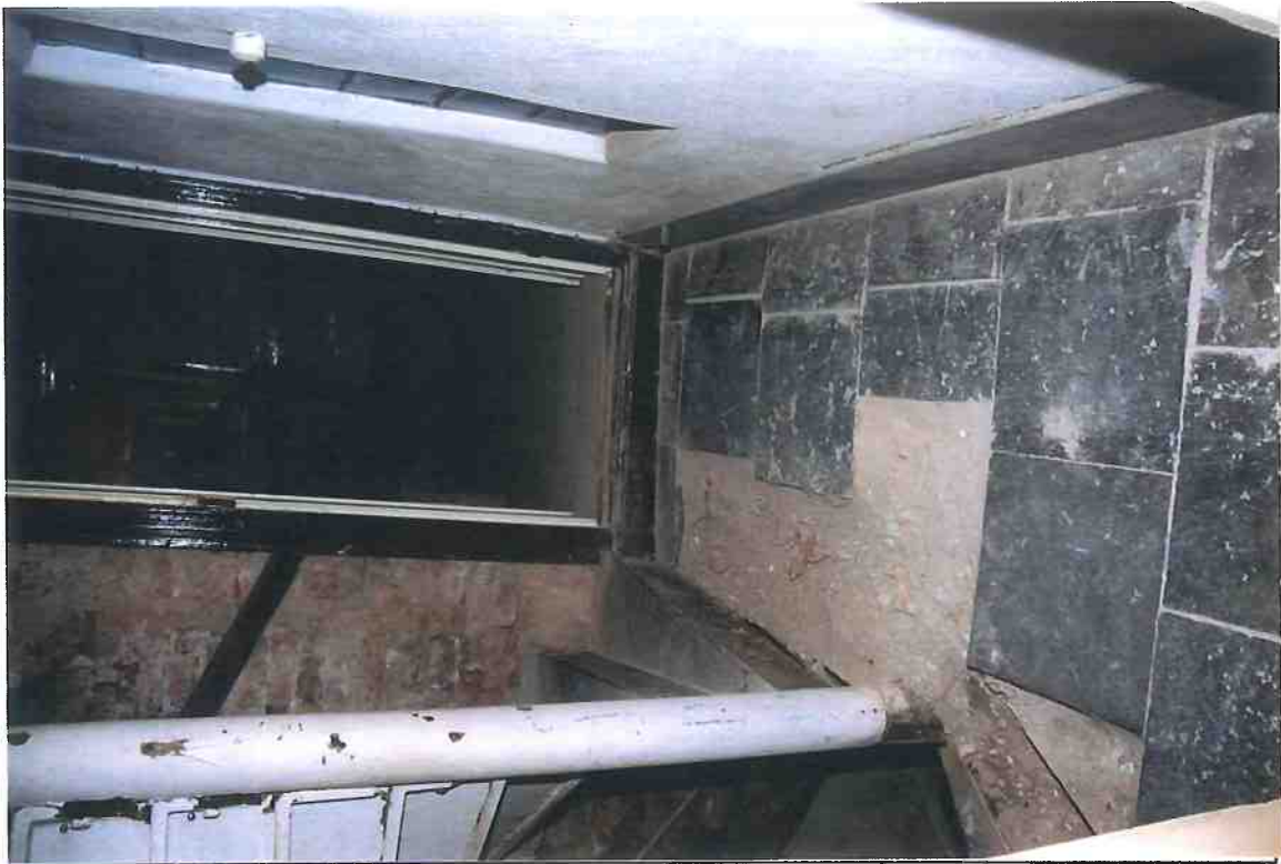
F3/10-11. Rum 203. Trapplanen präglas av järntrappans förbindelse mellan våningarna. Kalkstensgolvet är troligen från senare delen av 1800-talet och lagt över ett äldre brädgolv. Dörrfodren är av 1800-tals typ.
