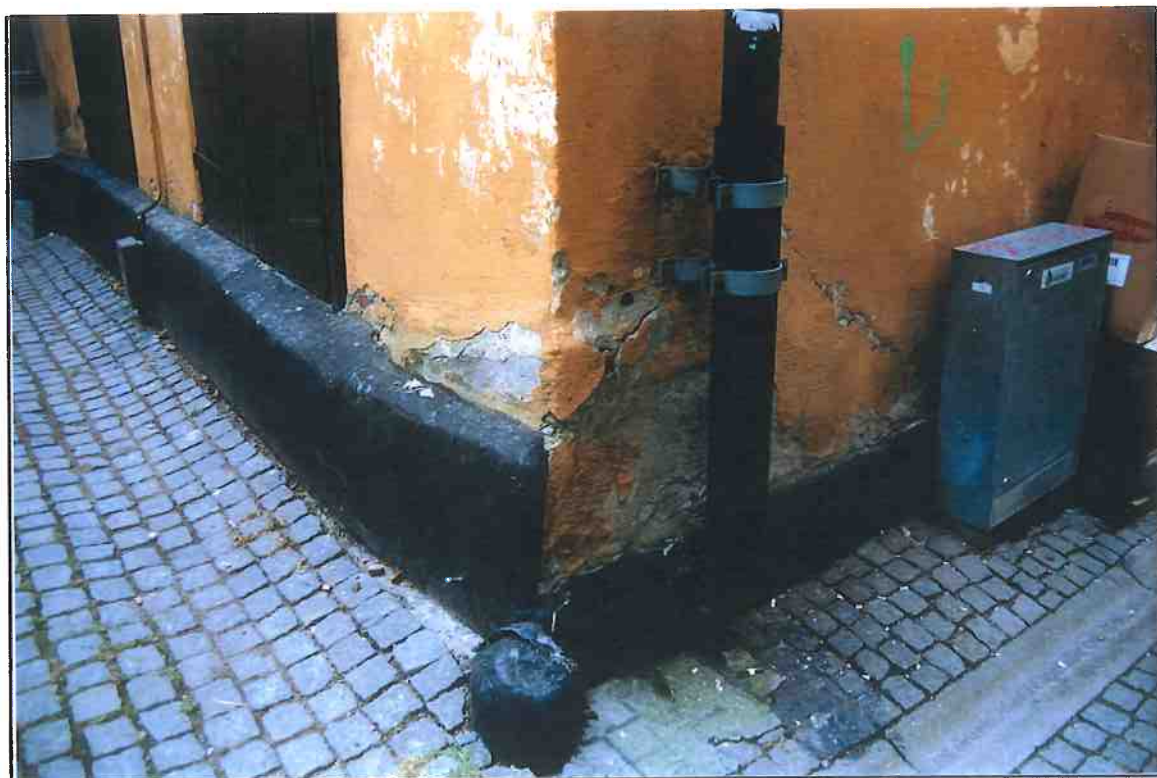
F5/20. Effekterna av sättningen i hörnet Brandplan-Sven Vintapparens gränd
