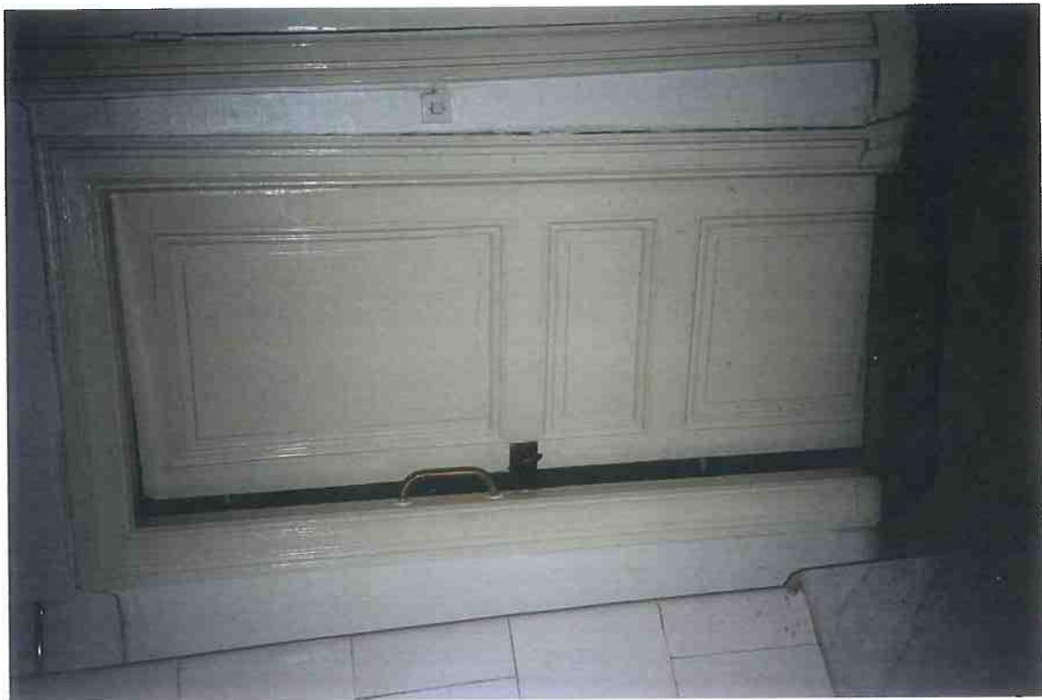
F2/6. Rum 204. Dörr D204/S-1 mot badrummet (202) har s.k. fransk indelning och är av en typ som förekommer mellan 1700-talets mitt och 1800-talets senare del.
