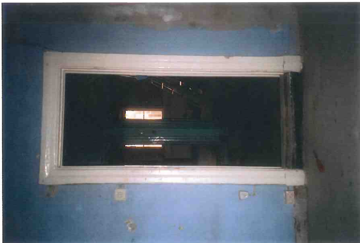
F4/17. Rum 401. Dörröppningen mot trapphuset. Dörrfoder fr. 1800-talets första hälft.
