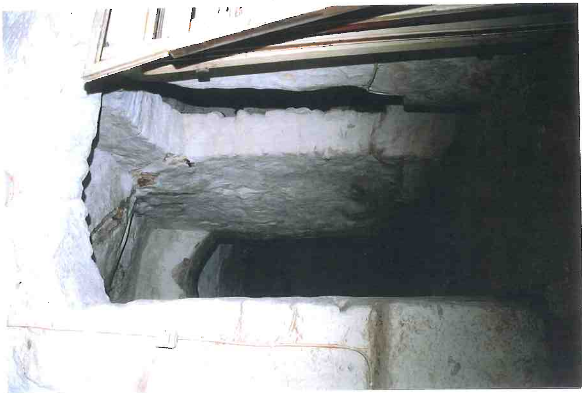
F1/20. Rum 003. Källargången mellan trapphus och övriga rummen.
