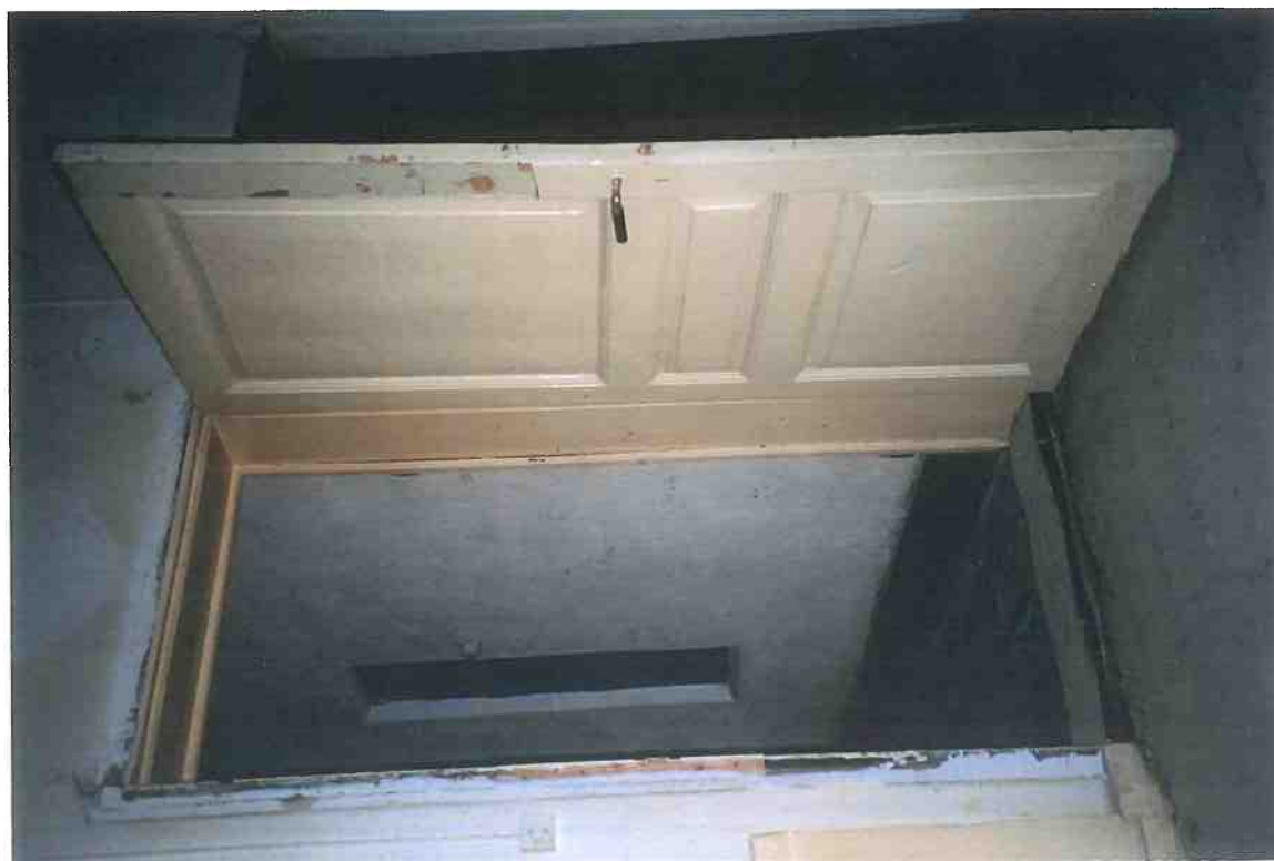
F2/17. Rum 201. Dörren (D201/n-1) mot trapphuset (203) har fransk indelning, typen förekom mellan 1700-talets mitt och 1800-talets senare del. Den är på insidan klädd med masonit som en följd av brandkraven. Det moderna dörrfodret är borttaget.
