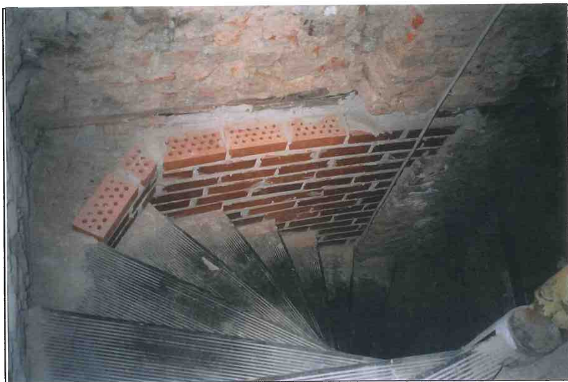
F4/1. Gjutjärnstrappan uppfördes troligen på 1880-talet. Pågående arbete i trapphuset.
