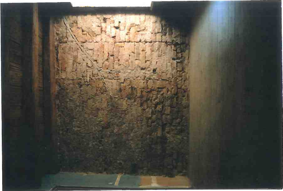
F5/8. Rum 401. Bortriven köksinredning från 1970-talet. Den igenmurade dörröppningen i brandväggen skapades 1872 som förbindelse med grannfastigheten.
