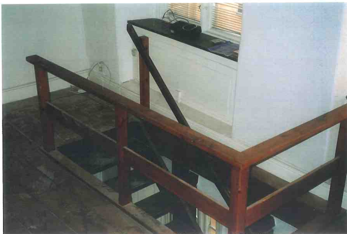
F4/11. Rum 304. Innertrappans anslutning med bjälklagsgenombrott, en skapelse från 1970-talet. Det gamla brädgolvet är slipat och lackat.
