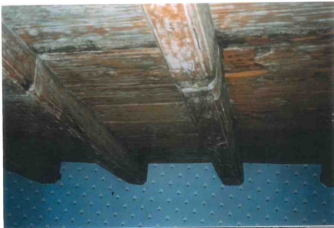
F6/9. Rum 403. Takbjälklagen har bjälkar med profilering i nedre kanter och bär brädtak. De flesta takbjälklagen i huset övertäcktes så småningom med paneltak och gipstak.
