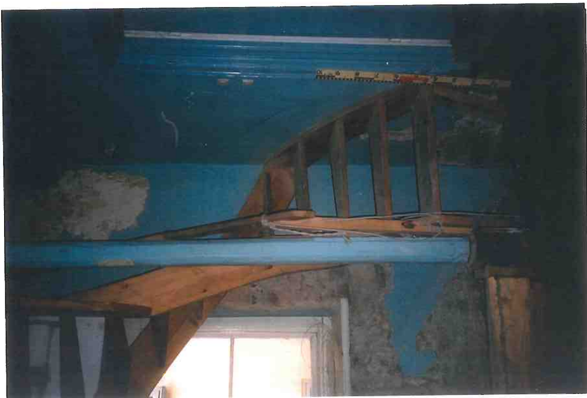
F6/13. Rum 402. Del av trapphuset med trapphusfönster och trappan mot vinden.
