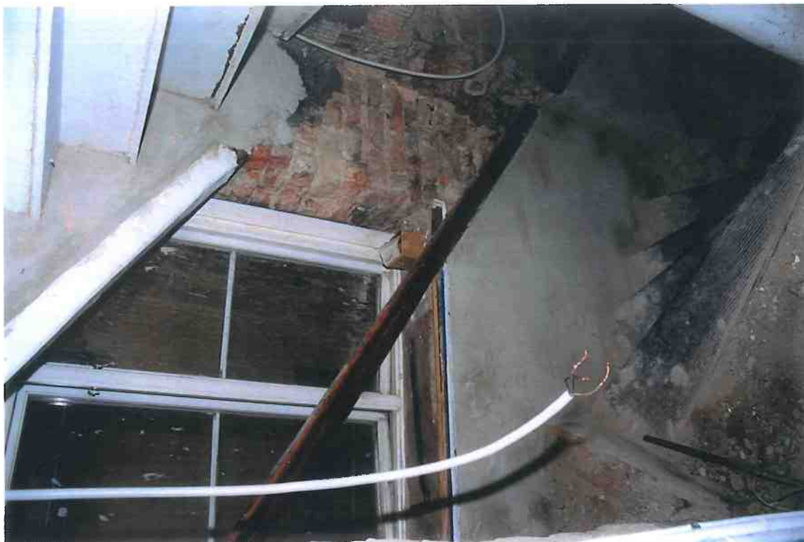
F3/13-14. Trapphus. Detaljer av trapphuset mellan plan II och plan III. Putsen är nedknackad och omputsningen påbörjad med hydrauliskt bruk upp till ledstången. I norra tvärmuren kan man tyda avlastningsbågen från en äldre öppning. Trapphusfönstret är i liv med övriga fönsteröppningar på plan II.
