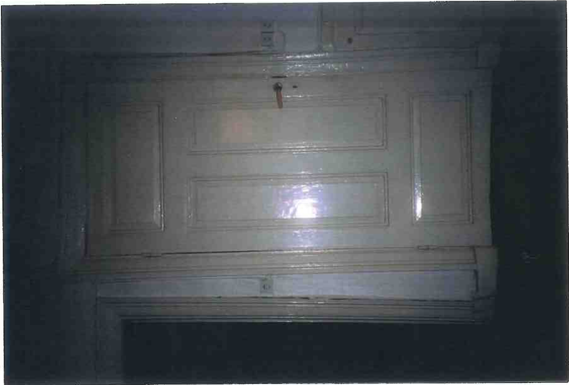
F2/4. Rum 204. Dörr D204/S-2 mot trapphuset (203) är av 1870-talstyp med stående och liggande speglar.
