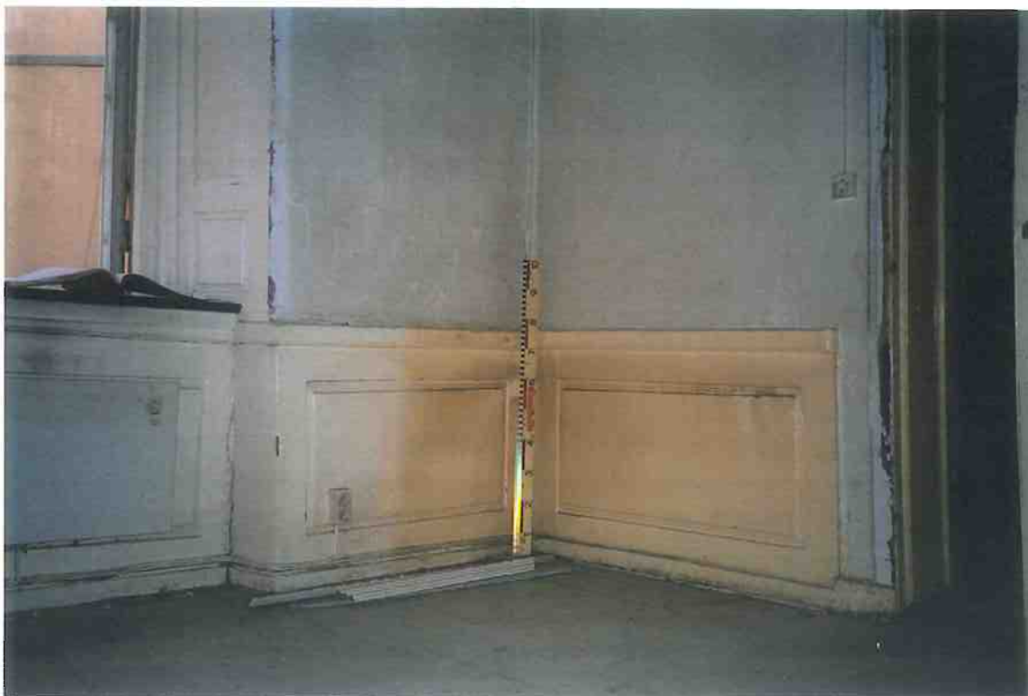
F2/18. Rum 201. Detalj av bröst- och smygpanelen samt brädgolvet.
