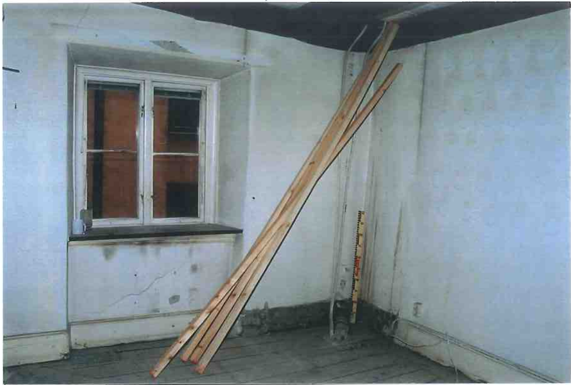
F5/2. Rum 301. SO-hörnet av rummet med genomgående rörstammar, delvis nedrivna. Rummet har ett enklare utförande utan bröst- och smygpaneler och med endast hög golvlist från 1800-talets första hälft.
