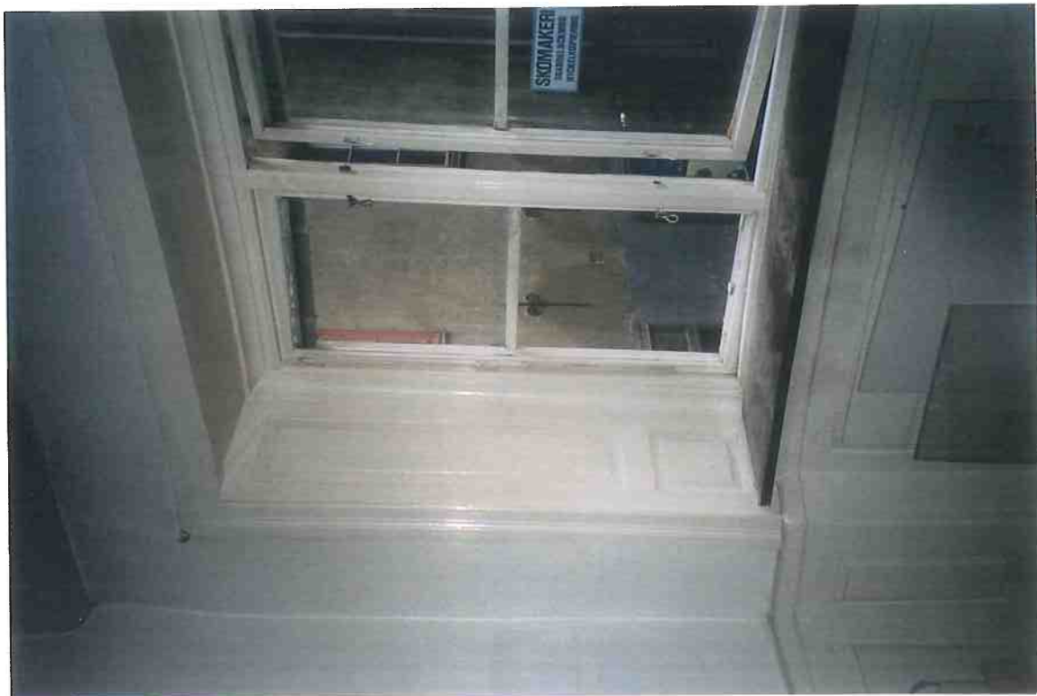
F2/14. Rum 204. Detalj av fönsternisch och smygpanel i norra gaveln (F204/N-2). Nuvarande fönster är insatta på 1970-talet liksom fönsterbänkarna av röd marmor.
