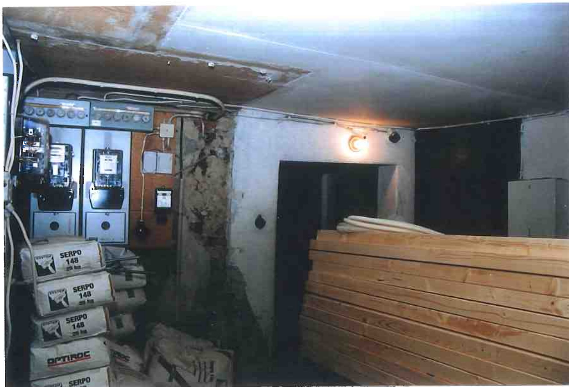
F1/4. Rum 101. Rummet har efter 1970-talets ombyggnad delats i flera utrymmen; bl.a. soprum, el-central, våtrum m.m. För tillfället är rummet under ombyggnad och skiljeväggar borttagna. Den framtida användningen är inte helt fastställd
