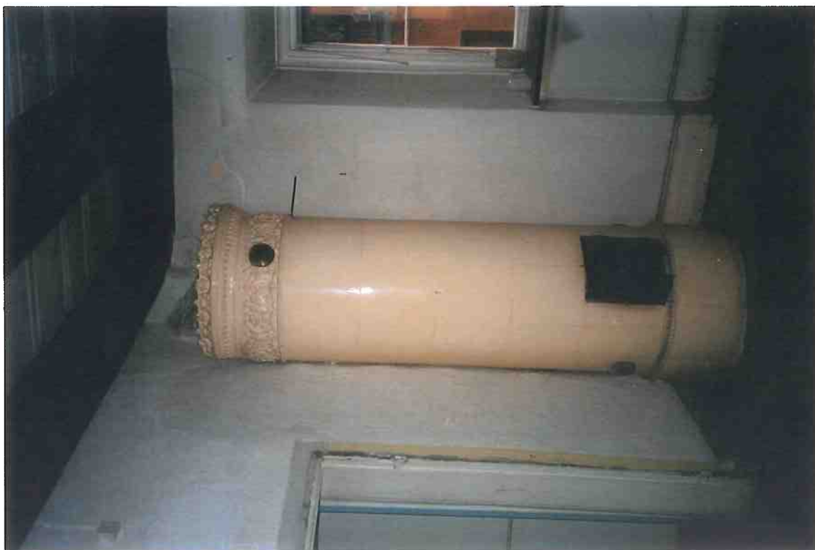
F4/4, F4/2. Rum 301. Fönstret i västra väggen samt övermålad kakelugn i rummets NO-hörn. Takbjälklagen har smyglister infällda mellan bjälkarna längs m. västra och östra väggarna, en åtgärd troligen från 1970-talet.
