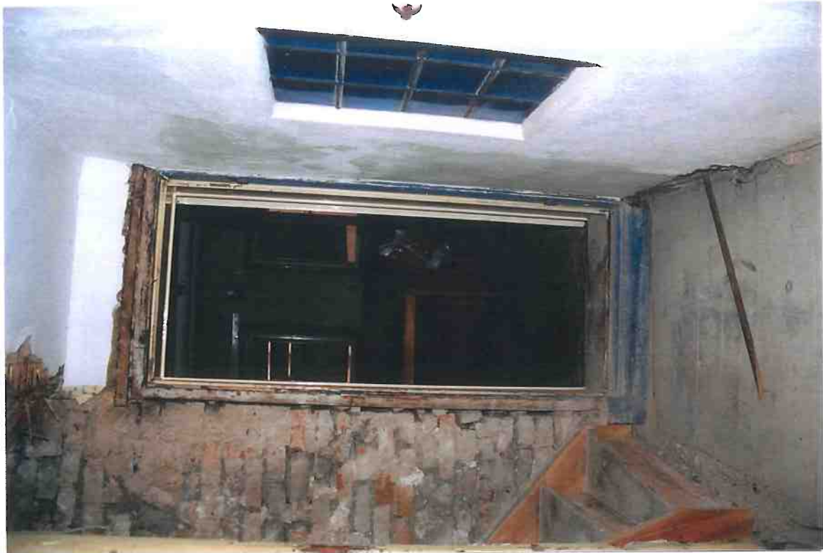
F3/19, F3/24. Rum 303. I höjd med plan III övergår gjutjärnstrappan (tidigare stentrappa) till trätrappa. Norra och södra dörrarna är från olika perioder och har därför olika höjder. I trapphusets östra vägg, mot nuvarande kök, finns resterna efter en forna dörröppning som på 1970-talet gjordes om till innerfönster med murat kepplerglas.
