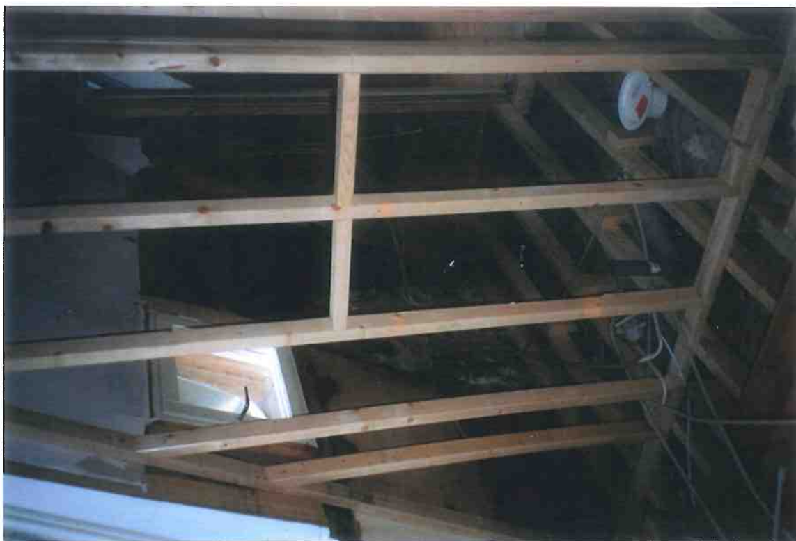
F6/19. Rum 501. Våningen är under ombyggnad och ett badrum under inredning.
