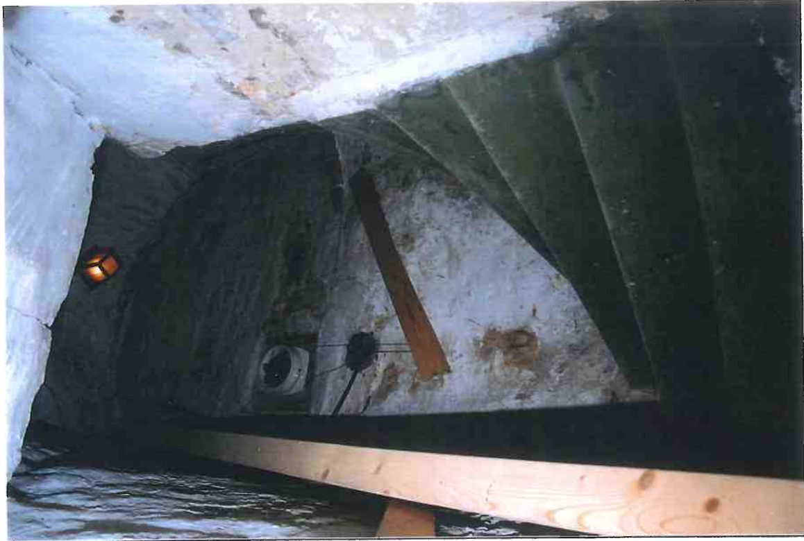
F1/12. Rum 002. Källartrapphus med betongtrappa (1970-tal). I östra väggen finns en fläktaggregat som är insatt i en gammal fönsterglugg.
