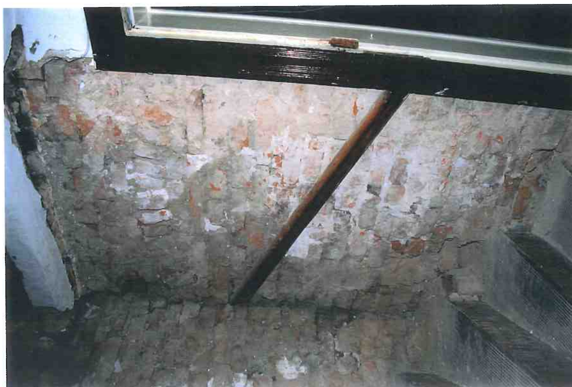
F3/13-14. Trapphus. Detaljer av trapphuset mellan plan II och plan III. Putsen är nedknackad och omputsningen påbörjad med hydrauliskt bruk upp till ledstången. I norra tvärmuren kan man tyda avlastningsbågen från en äldre öppning. Trapphusfönstret är i liv med övriga fönsteröppningar på plan II.
